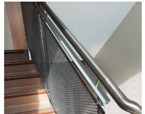
Die alten Geländer mit Holzelementen werden gegen nicht brennbare Edelstahlgeländer ausgetauscht.
